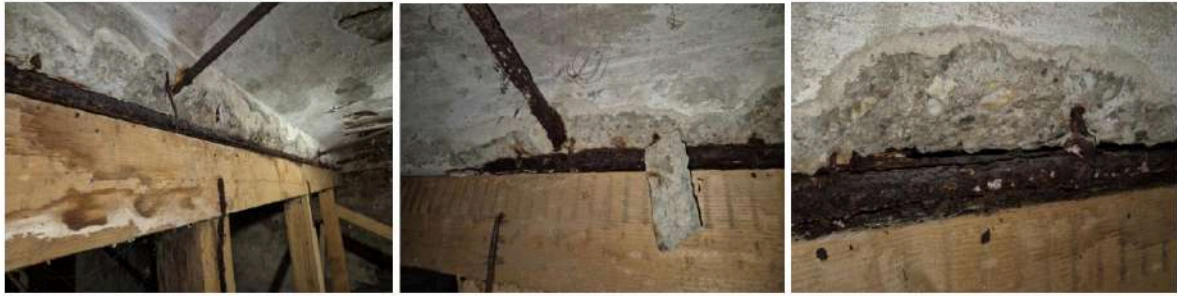
52., 53. és 54. fotók: A vasbeton borda károsodásának nagysága
